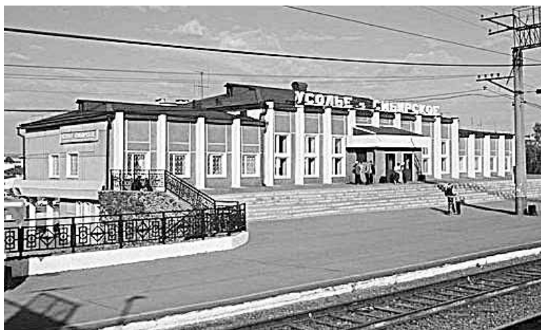
Усолье-Сибирское. Железнодорожный вокзал. 2013 г.
