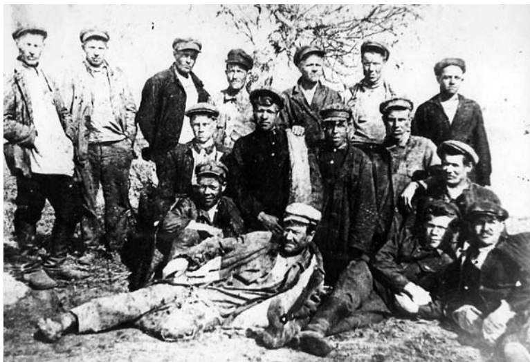
Строители железнодорожной ветки от химкомбината до станции
